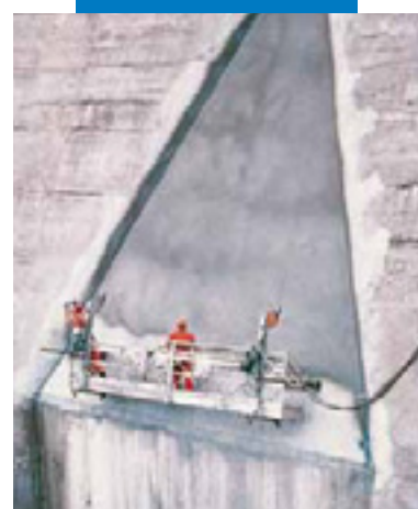
大坝喷涂 马贝弹性防水砂浆331 施工图例
