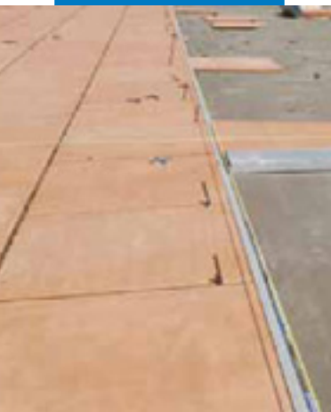
使用马贝瓷砖胶101+马贝乳液112粘贴瓷砖
