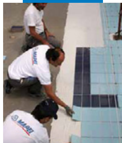
施涂马贝弹性防水在游泳池的马贝弹性防水砂浆331防水层上铺瓷砖
