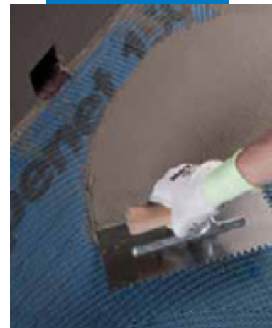
施涂马贝弹性防水砂浆331于马贝耐碱玻纤网150上
