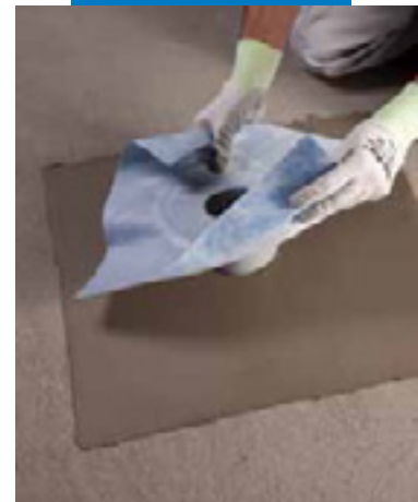
立面排水孔施涂马贝弹性防水砂浆331
