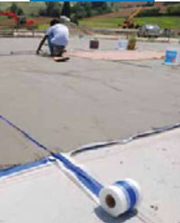
马贝弹性防水砂浆331和马贝防水带331作地坪防水
