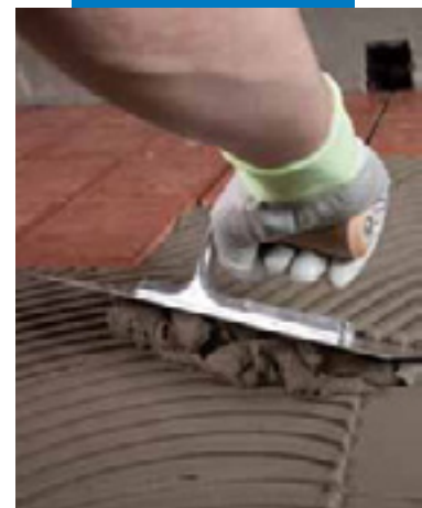
露台上作马贝弹性防水砂浆331后, 施涂马贝瓷砖快胶113.
